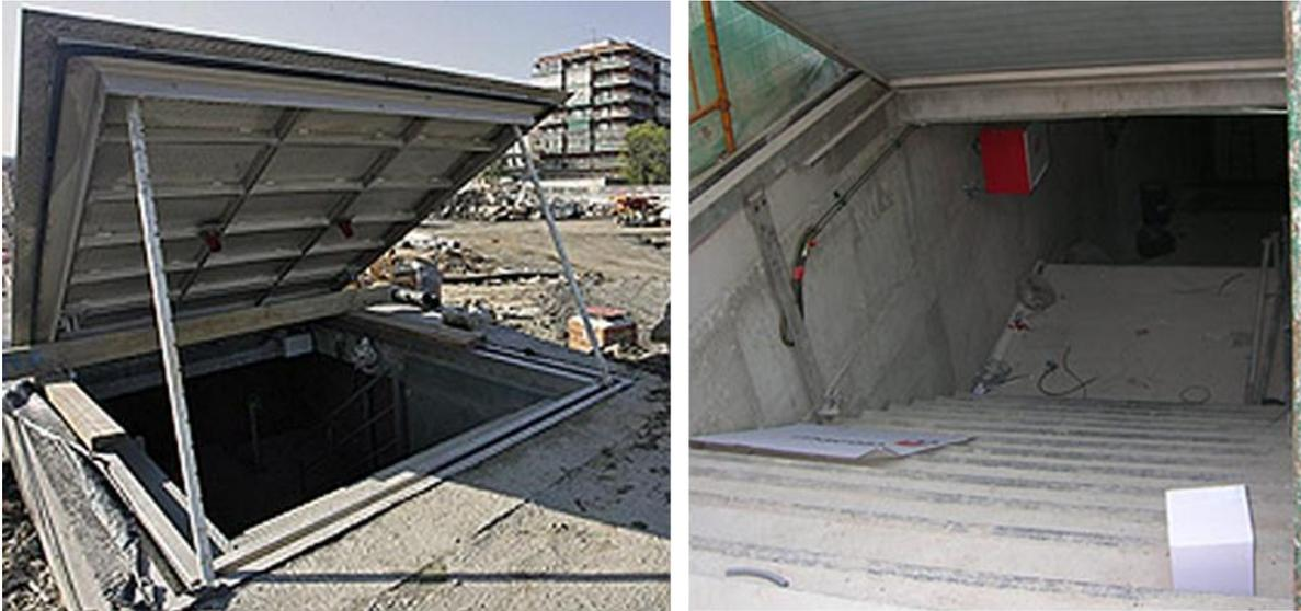
**Figura 51: Salida a superficie de las vías de escape**
